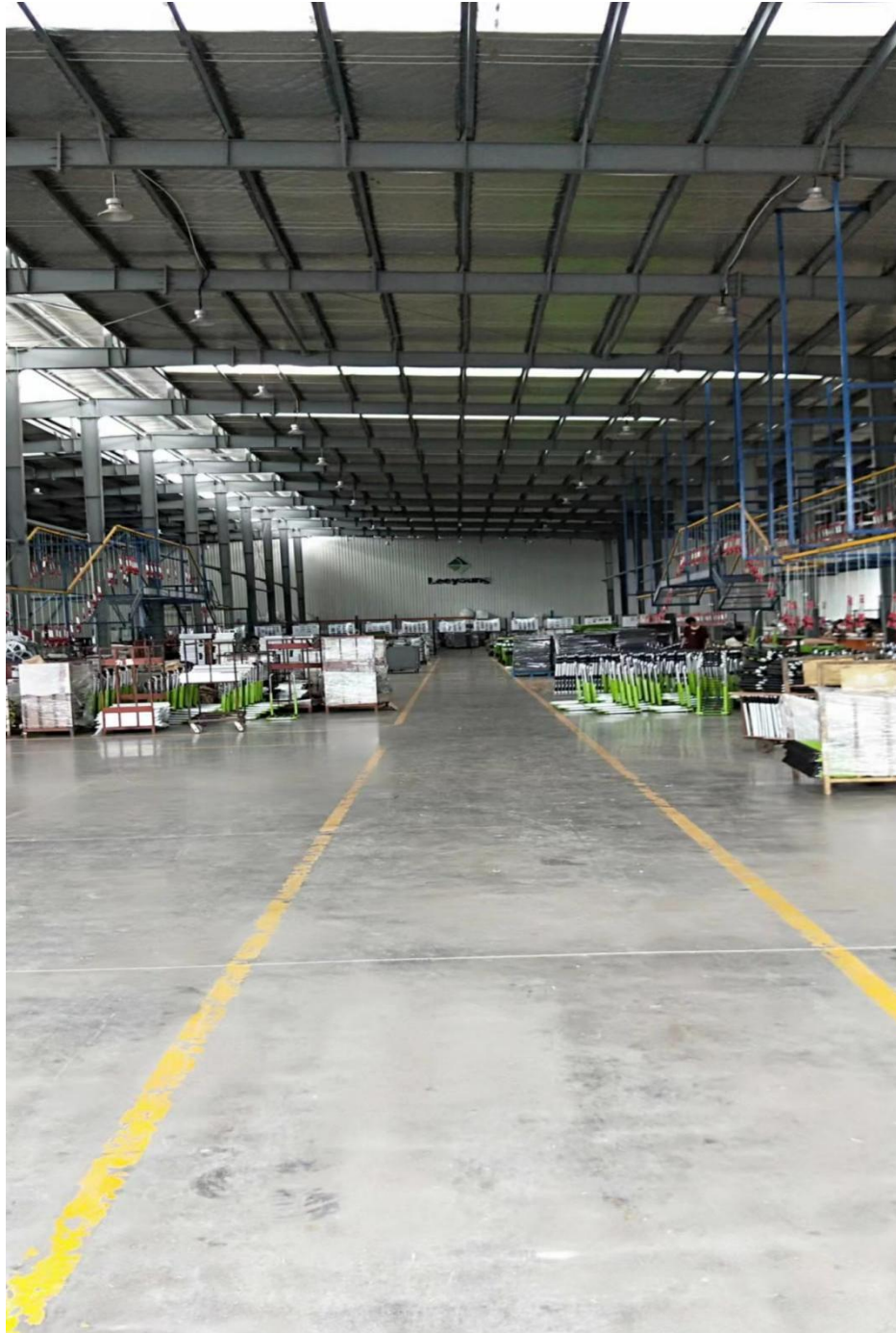
图1 车间生产现场
